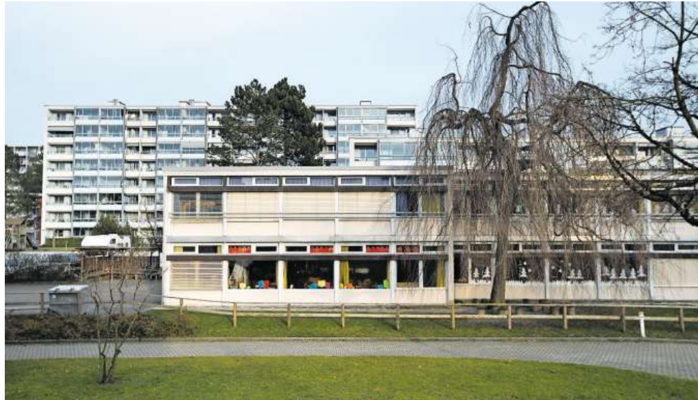
Hier soll ein Quartiertreffpunkt entstehen.
